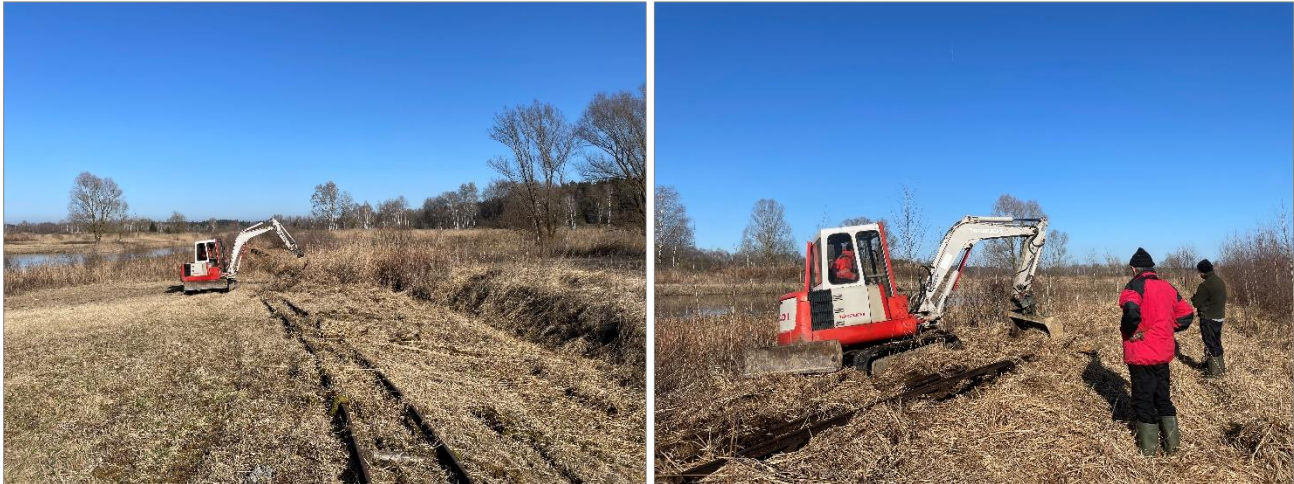
Mittels Bagger wurden die Gleise aus der Streuwiese entfernt und so die Bewirtschaftung erleichtert (Foto: Karin Moosbrugger)
